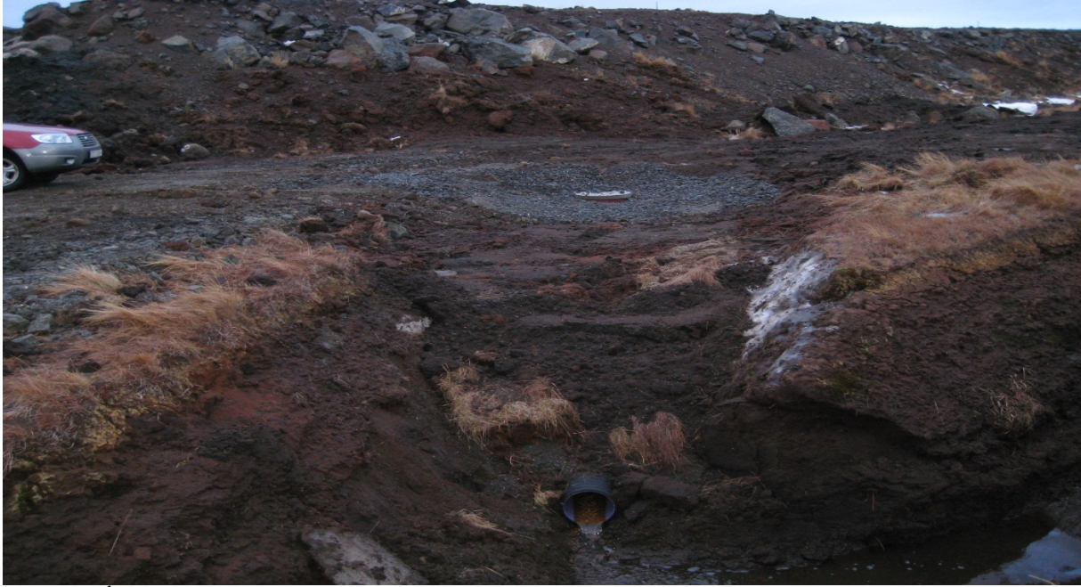
Mynd 8: Útrás frá urðunarein 4 í Fíflholtum (við suðurhorn reinarinnar). Þarna var áður steinrör, en nú hefur verið komið fyrir olíu- og fituskilju (undir hlemmi á miðri mynd) og nýrri plastlögð þaðan út í skurðinn. Framvegis verða sýni tekin þar til efnagreiningar. (Ljósmynd. S.G. 22. janúar 2014).
